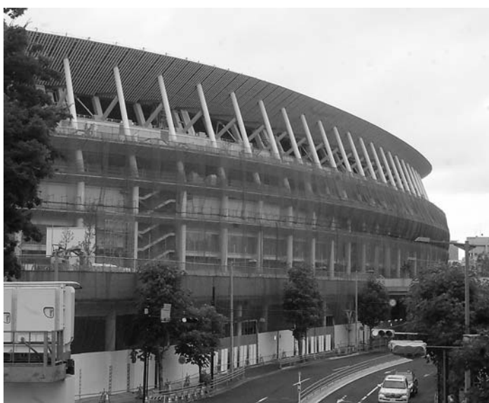
周辺工事が続くメインスタジアム
