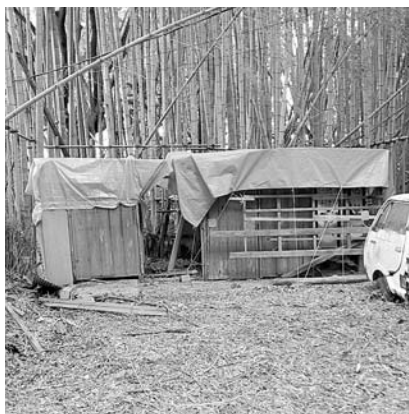
横堀農業研修センターの被害状況
