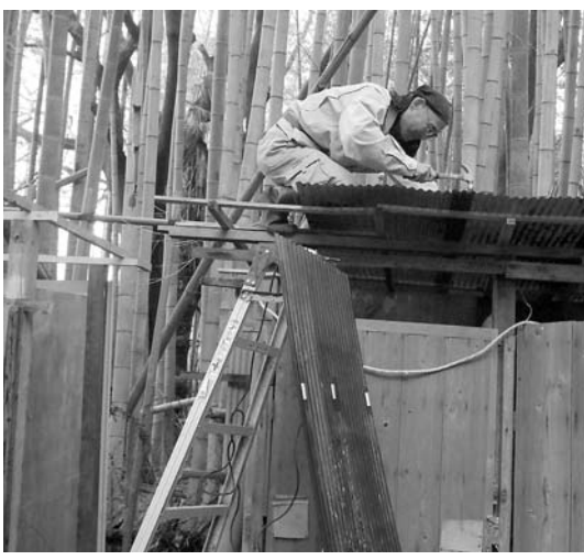
10月26日、三里塚大地共有運動の会は台風15号で被害を受けた横堀農業研修センター修繕作業を行った。
